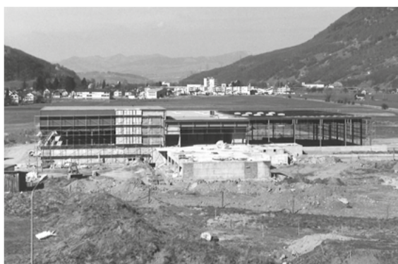
1974/1975 Das SGU im Bau – durchaus bekannte und mittlerweile wieder aktuelle Bilder.
