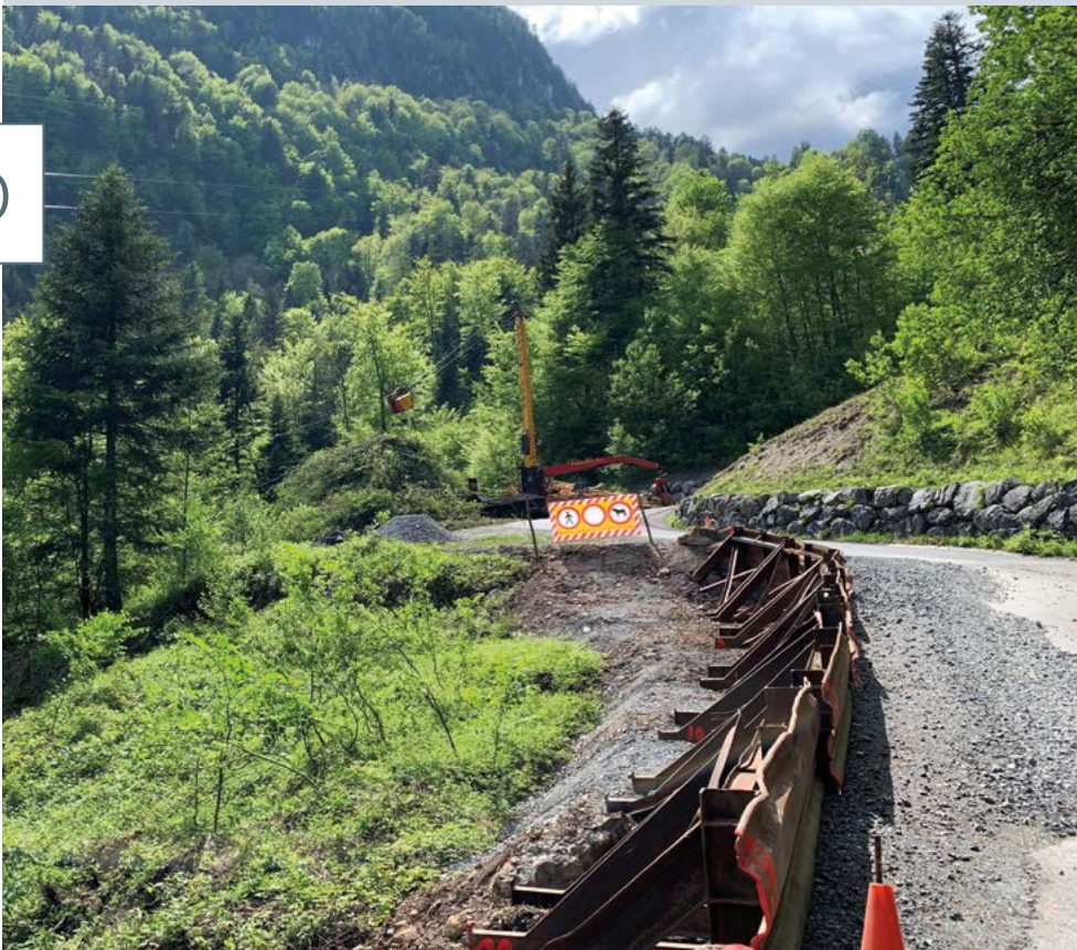
Sofortmassnahmen nach Hangrutsch im Niederurner Täli.
