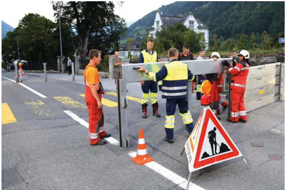
Errichtung einer temporären Strassenbarriere in Glarus Süd.
